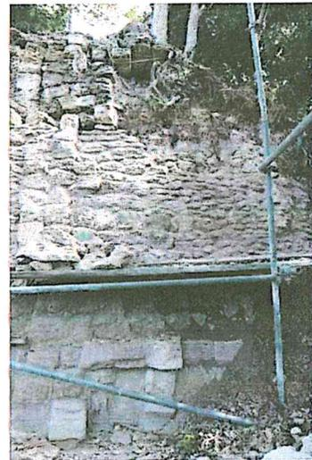
En la fachada oeste se trabajó en la recuperación de volumen perdido en el núcleo de la pirámide en donde se estabilizó una superficie de 35 m<sup>2</sup> del talud en el penúltimo cuerpo.
