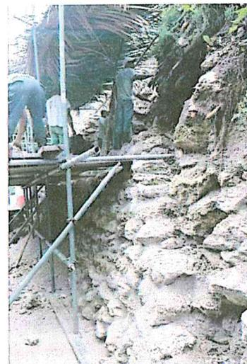
4. En el edificio B-17 en la Acrópolis Central se trabajó en la restauración de 25 m<sup>2</sup> de las escalinatas liberadas durante los meses de junio y julio del 2019. Como parte del trabajo se estabilizó el núcleo de la construcción y se rellenó un túnel de 7 m de largo.
